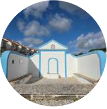
1 FONTE DA ÁGUA FÉRREA
